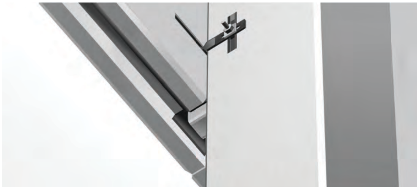
Apoyo panel en pilar con ménsula metálica
