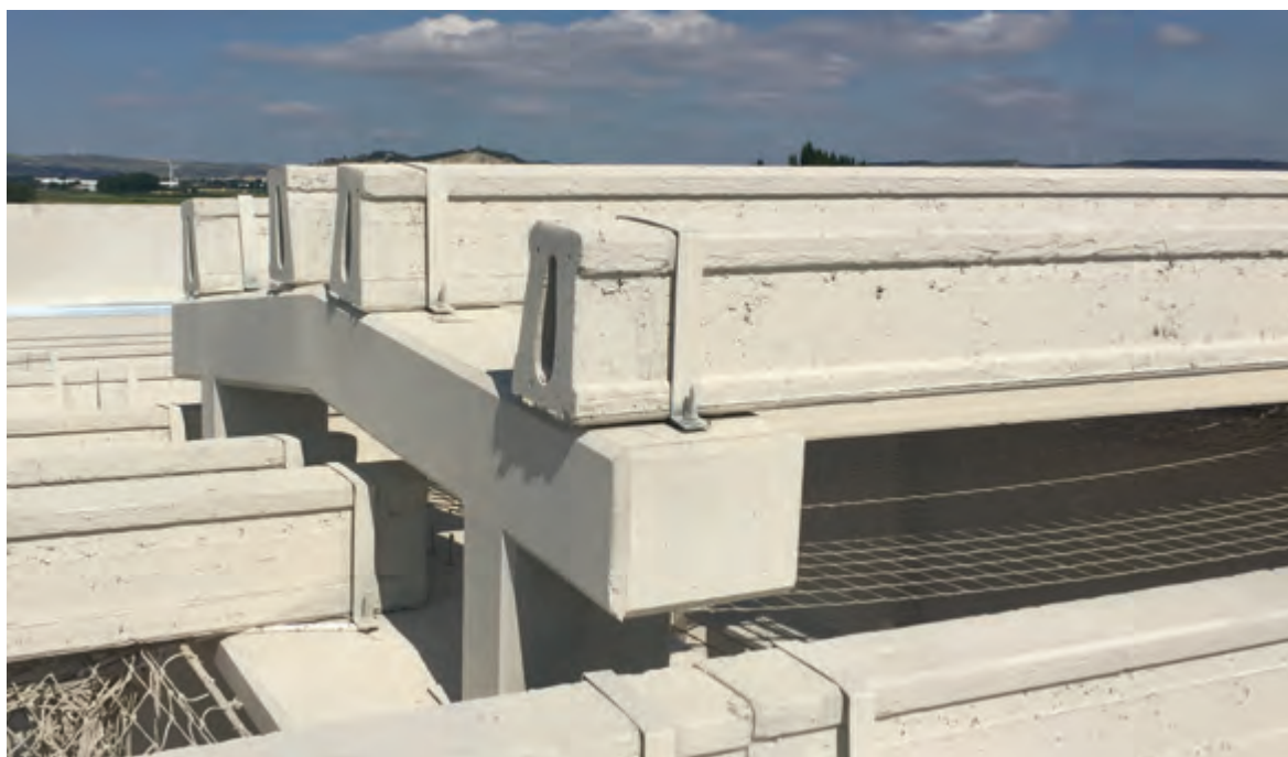
Pórticos de ventilación con apoyo de 2 viguetas
