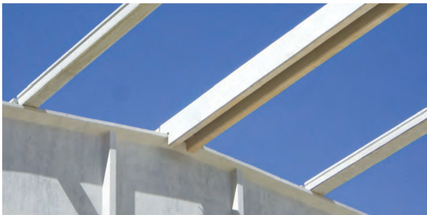
Atado de vigas en extremo
