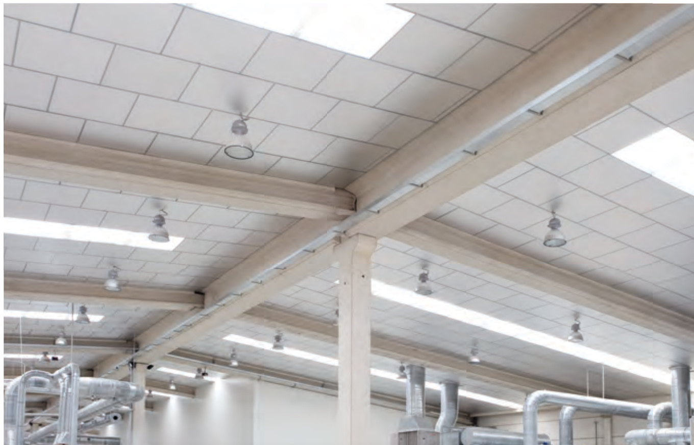
Apoyo de viga peraltada sobre ménsulas de viga salvapilar
